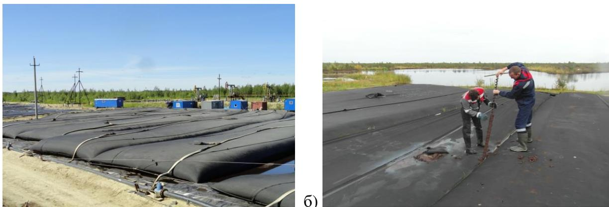
**Рис. 1.** Геоконтейнеры на технологической площадке (а); отбор проб пробоотборником (б).
